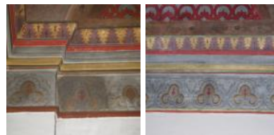
Dettaglio cornice prima e dopo intervento
