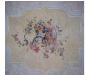
Volta prima e dopo intervento
