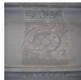
Tassello di discialbo cornice
