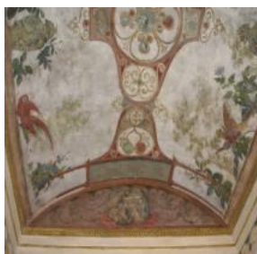
Volta prima e dopo intervento
