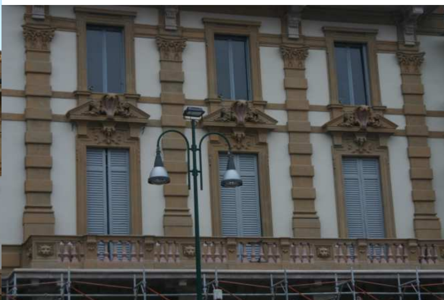
Particolari della facciata dopo il restauro
