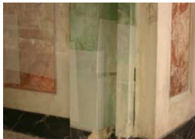
Particolari impacchi desalinizzanti con carta giapponese e solvente volatile a bassa percentuale in acqua
