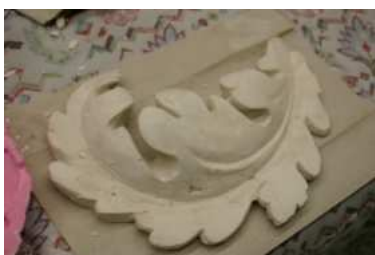
Ricostruzione in stucco da calco speculare
