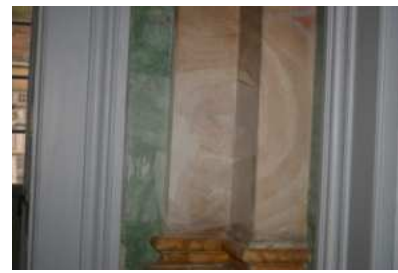
Particolari impacchi desalinizzanti con carta giapponese e solvente volatile a bassa percentuale in acqua
