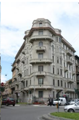
Dopo il restauro
