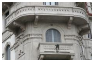
Particolare dopo il restauro
