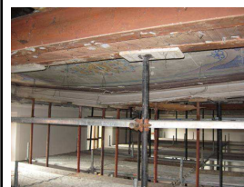
Area deformata e lesionata, da cui si vede la struttura portante ad incannucciato
