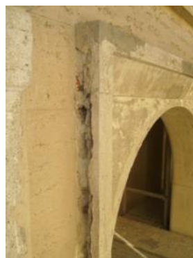
Eliminazione stucature cementizie
