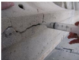
Consolidamento ad iniezione
