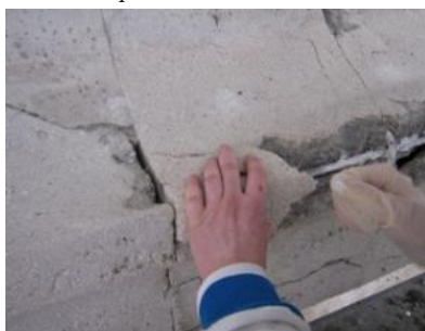
Ricollocazione parti originali dopo trattamento dei ferri
