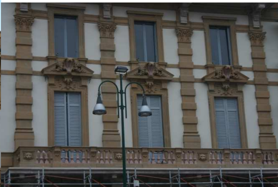
Particolari della facciata dopo il restauro
