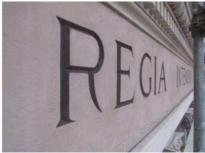
Fascia dopo il restauro
