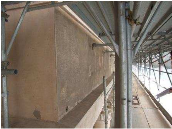
Fascia prima del restauro
