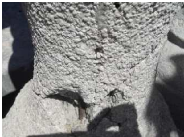
Degrado dovuto al ferro
