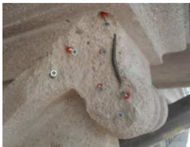
Impernatura con viti in acciaio
