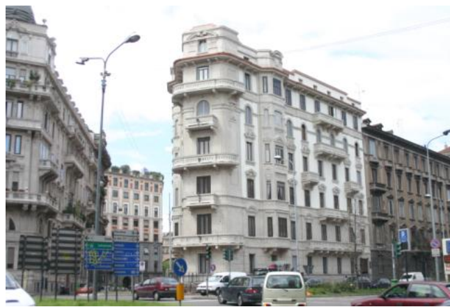
Facciata in viale Maino dopo l'intervento di restauro
