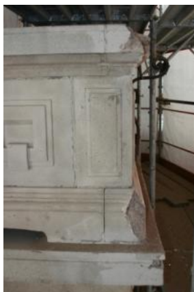
Particolare di un balcone prima del restauro
