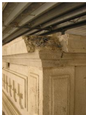
Preparazione per rifacimento
