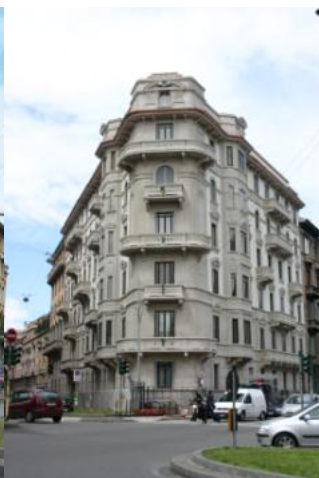
Dopo il restauro
